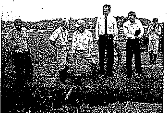
芥川改修の現場調査。汲川原地区の皆さんと芥川の改修について国、県、市の職員と共に要望を聞き取りました。
