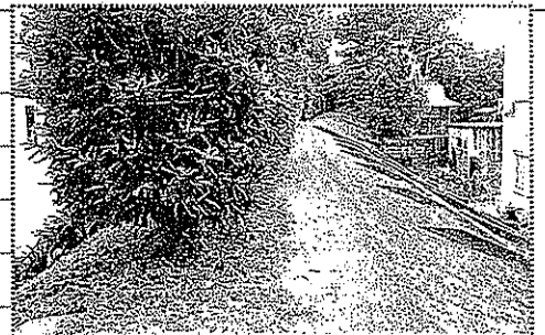
郷土の偉人、浜口梧陵が安政の大津波の後、復旧工事で築いた堤防。後の昭和の東南海津波でしっかり町を守った！
