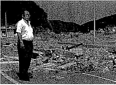
宮城県女川町災害現場
