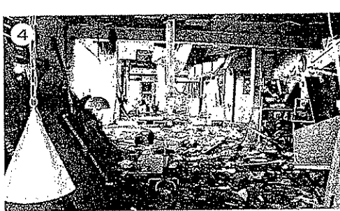
【8/5】金石市の駅前商店街の被災状況。 大津波の襲来で激しい損傷状態です。
