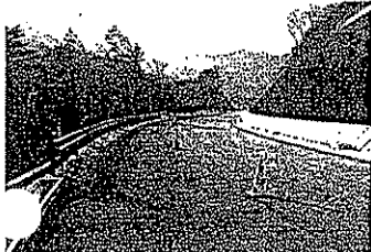
道路改良国道421号 石橋トンネルへの取り付け道路、来年のトンネル開通に向けて工事が進んでいます。
