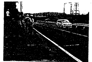
海蔵寺歩道拡幅現地検分
