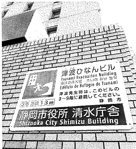
△清水庁舎は津波浸水域で職員の参集も危険
