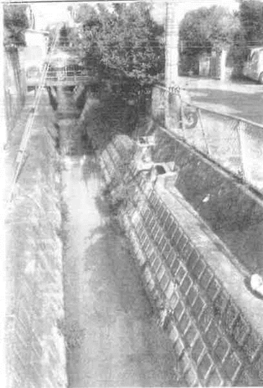
大雨の際に浸水被害が発生してきた「石嶺雨水幹線1号」(3日、那覇市首里)
