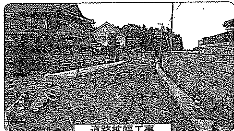
道路拡幅工事
